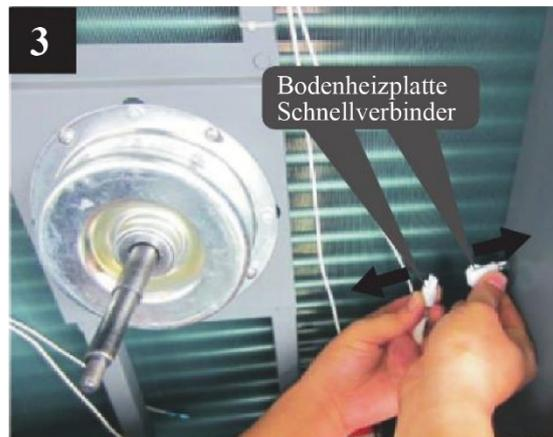
4. Setzen Sie eine neue Bodenplattenheizung ein und schließen Sie sie an den Schnellanschluss an.
